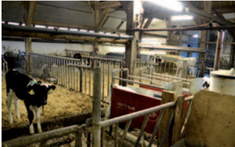
De stal waar tot vorig jaar het melkvee van Henk en Louise liep, is omgebouwd en dient nu als jongveestal
