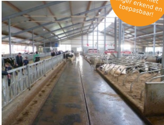
Herakles (gietasfalt op afschot met giergoot)
